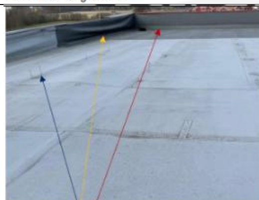
Nappeskader i forbindelse med nestenavblåsning Se skruer i hull Løs parapet
